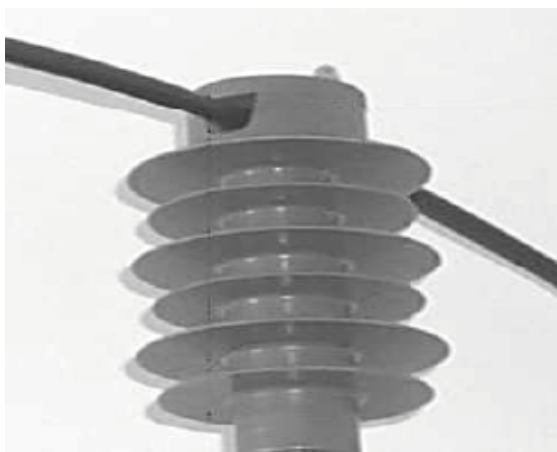
Figure 6. Exemple d'un câble isolé (câble noir), utilisé en Hongrie (source : Podonyi, 2011).
