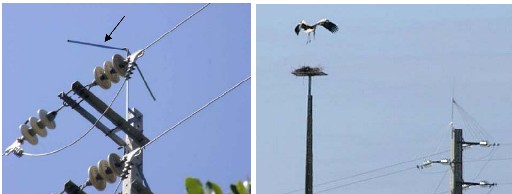
Figure 11. Poteaux électriques avec chevron symétrique (voir flèche) au sommet comme dispositif d'exclusion (Photo : EDP-Distribution, Portugal) ; et poteaux électrique avec pointe d'exclusion d'oiseaux et poteau de nidification pour cigognes blanches juste à côté)
