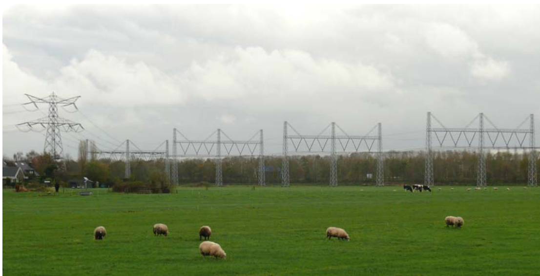
Figure 17. Ligne de 380 kV, les câbles étant suspendus plus bas sur des portiques sur un seul plan horizontal afin de réduire les risques de collisions pour le grand cormoran ( Phalacrocorax carbo ), la spatule blanche ( Platalea leucorodia ) et le héron pourpre ( Ardea purpurea ) passant tous les jours au-dessus de cette ligne en faisant des aller-retour entre la colonie en reproduction et les zones d'alimentation, Muiden, les Pays-Bas (Photo : Bureau Waardenburg).
